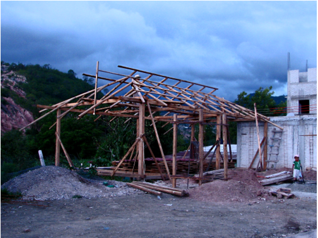
El armazón de una casa de madera (agosto de 2008)
